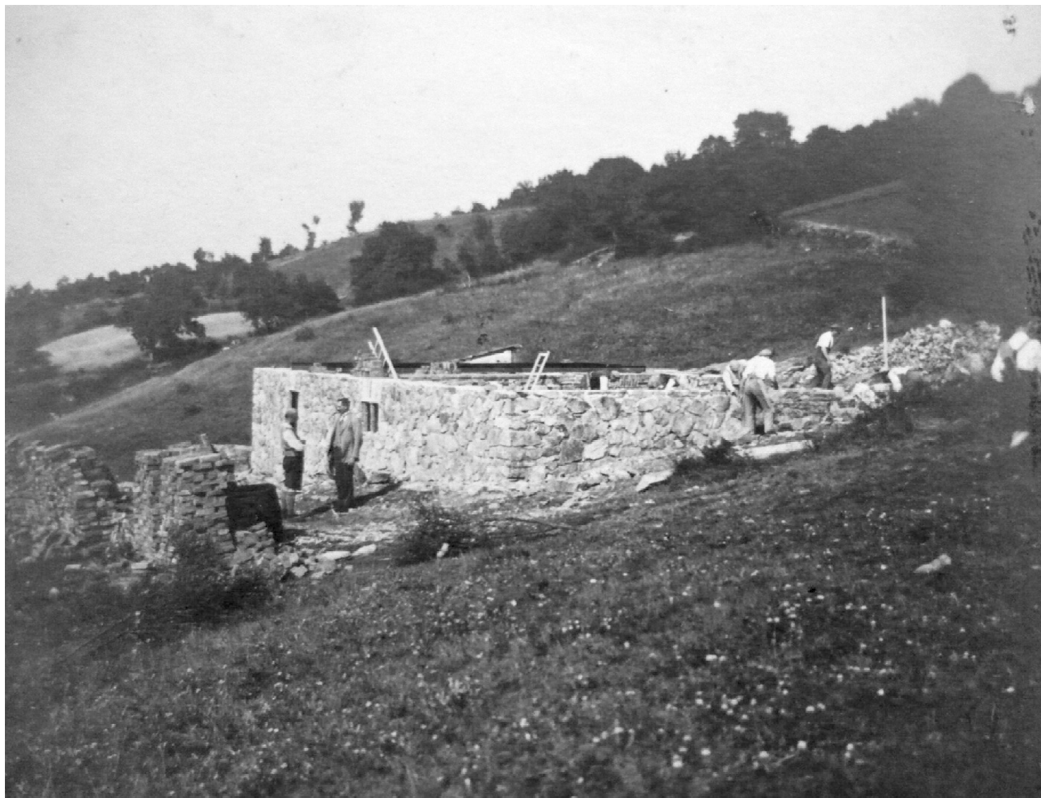
Počátky stavby, na podezdívku byl použit místní znělec.
